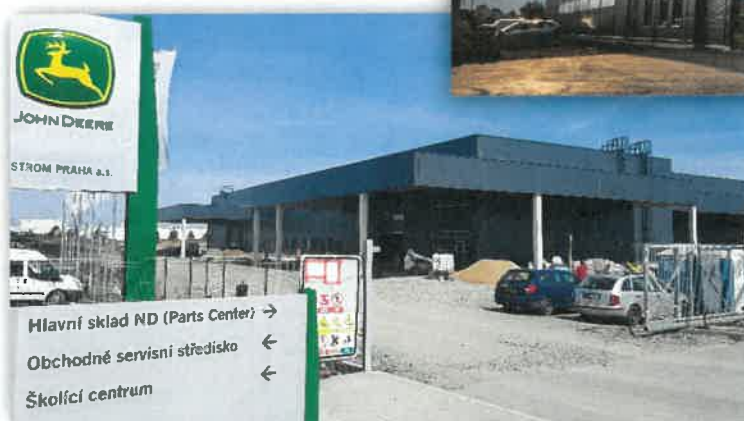
Výstavba centrálního skladu náhradních dílů v Ovčárech u Kolína
